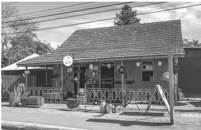
Fachada do Armazém Santa Ana. ANO: 2011 AUTOR: TAKEUCHI, Washington ACERVO: Particular
